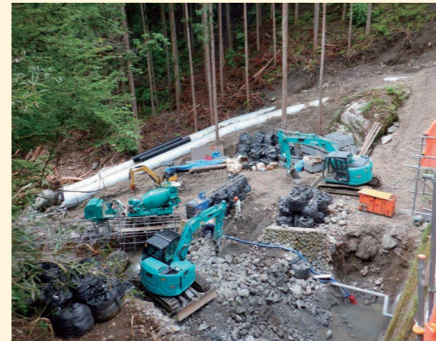
施工状況。大型重機は自走にて
