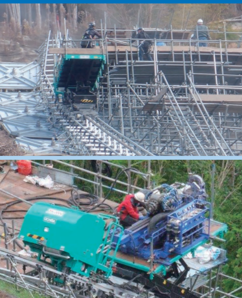
台車をステージの高さに合わせ削孔機を荷下ろし
