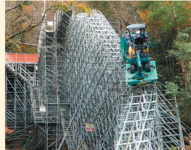
高低差最大12mの傾斜を登降坂し安全に重機運搬中
