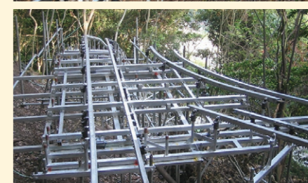
2条ワンタッチ切替ポイント(右直線切替状態)
