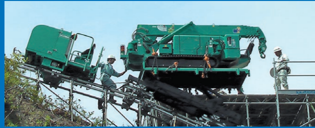
フラットデッキダンプにて3.7tクローラクレーン運搬中
