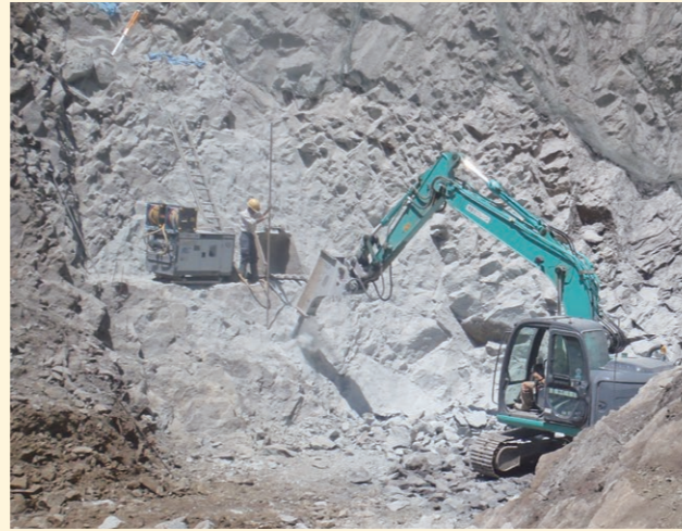
バックホウのブレイカーにて削岩
