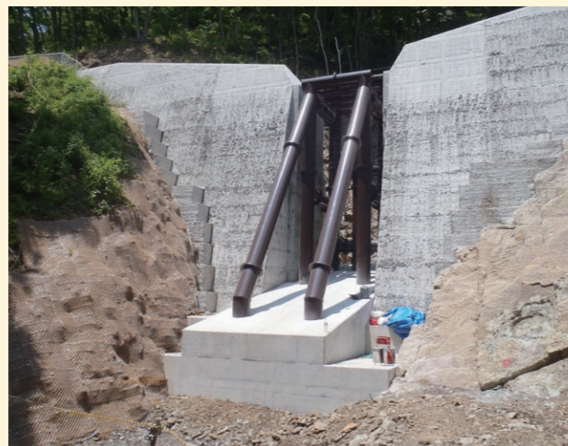
砂防堰堤の完成
