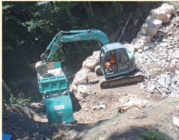
掘削土砂を2t三転ダンプ台車にて搬出
