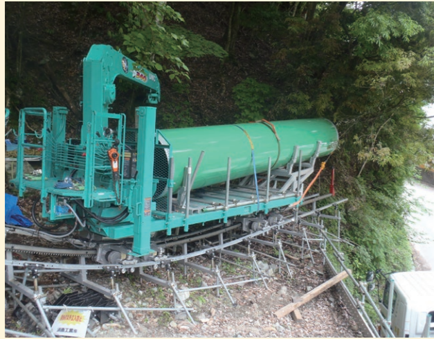
道路脇狭小地よりスタート
