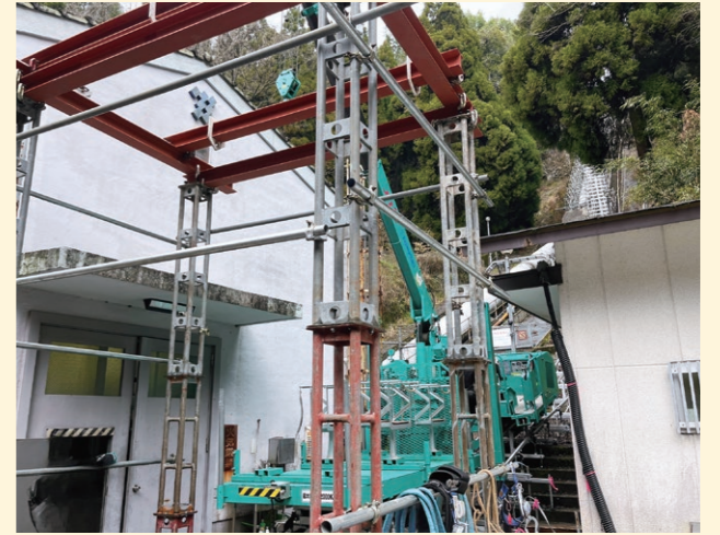
2tクレーン台車を使用し門型クレーン作成
