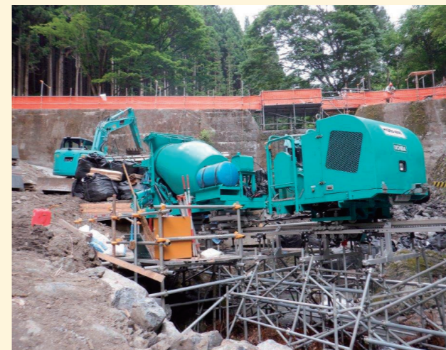
1mミキサー台車で生コンを攪拌しながら運搬
