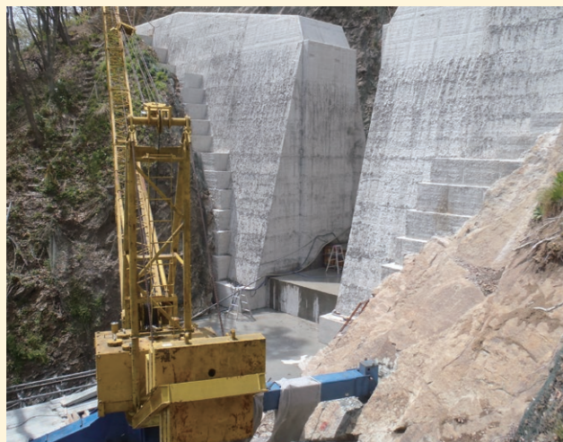
ジブクレーンを現場組立
