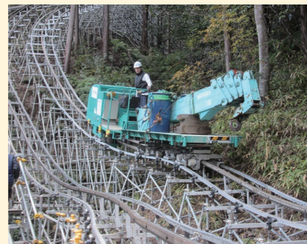
4.9tクローラークレーンを分解運搬中
