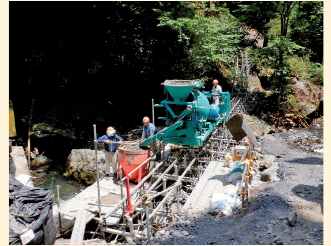
ミキサー台車から生コンホッパーへ移す
