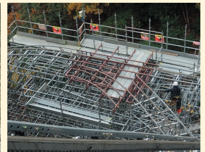
上部より切替ポイントを見下ろす
