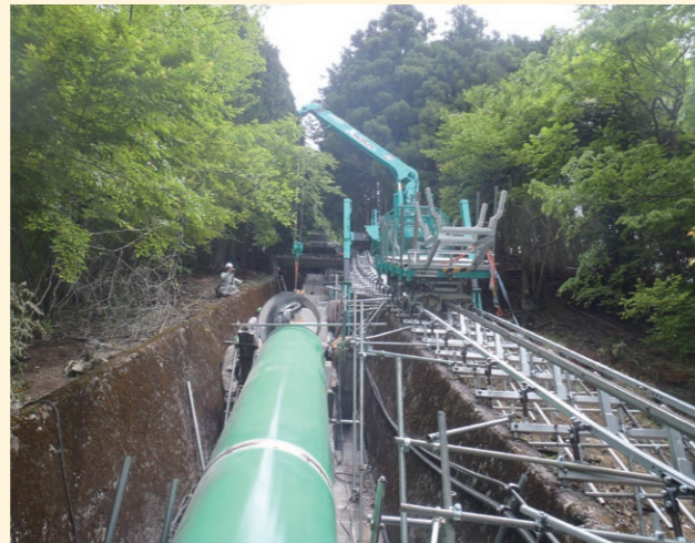
2tクレーン台車にて水圧鉄管を吊下げ中
