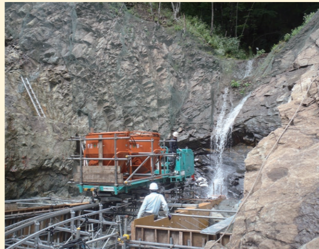
モノレールにて生コン運搬・打設
