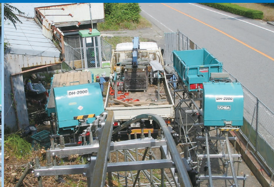
1t油圧ダンプ台車にて碎石搬出
