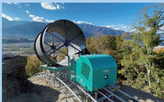
Φ3000の水圧鉄管を運搬
