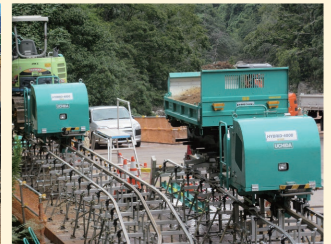
フラットデッキダンプ台車で重機運搬及び2t三転ダンプ台車で土砂搬出
