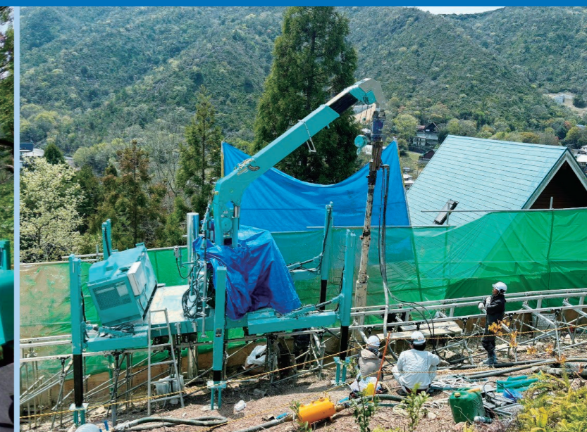
落石防護柵の支柱を設置
