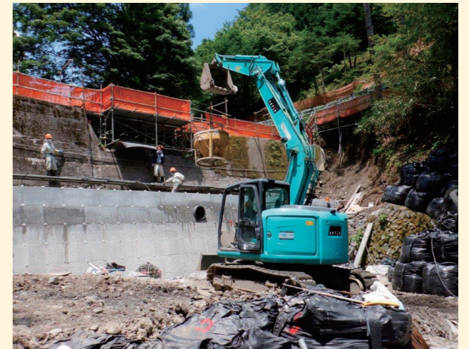
生コンホッパーをバックホウにて振り打設
