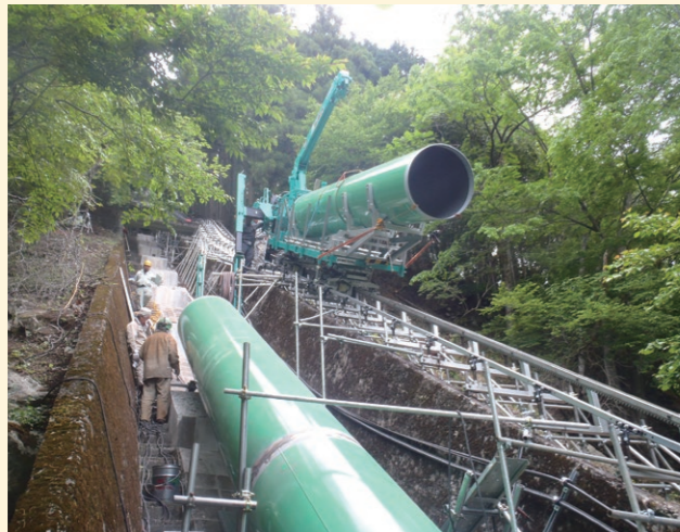
古い鉄管除去後、新しい水圧鉄管を運搬
