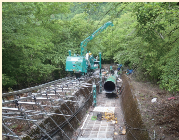
水圧鉄管を固定中
