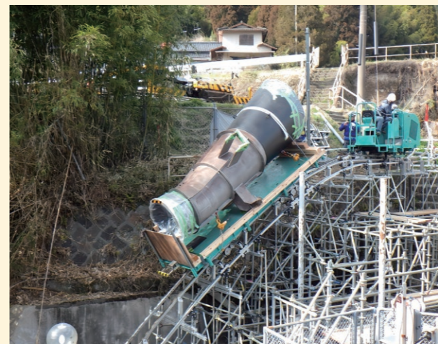
吸出し管を運搬
