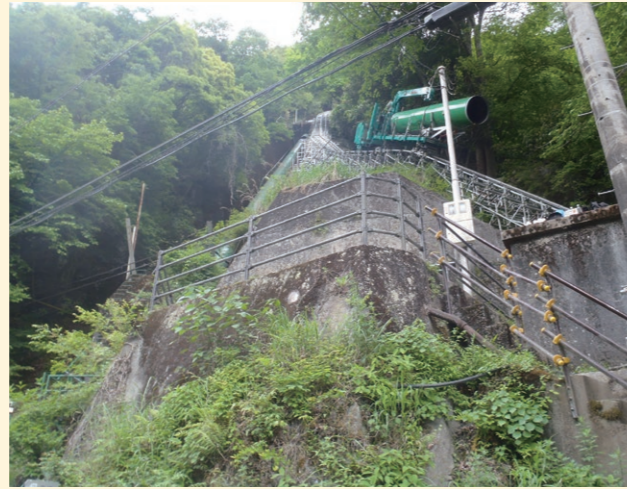
水圧鉄管沿いにレールを設置
