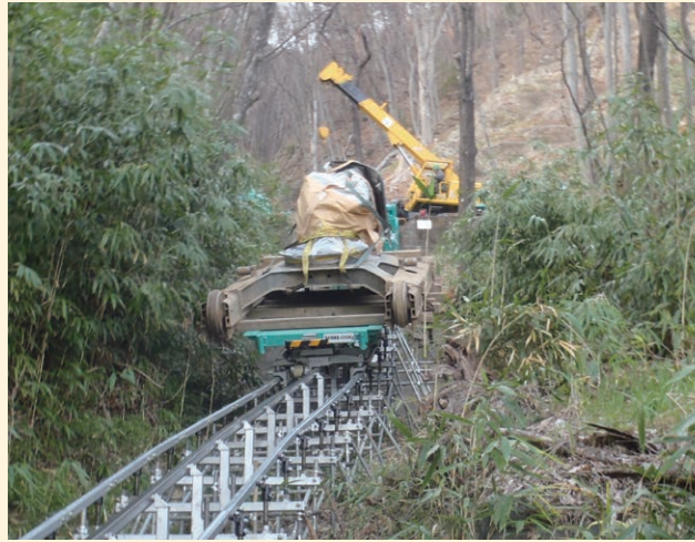
0.4mバックホウを分解して運搬中
