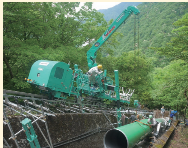
水圧鉄管を固定中
