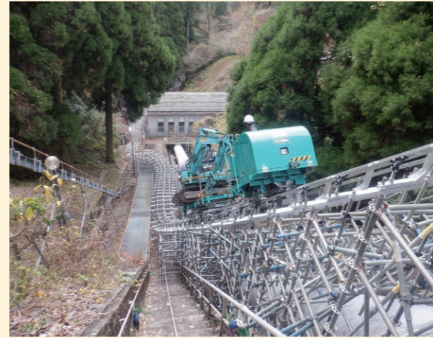
3.6tバックホーを運搬し建屋内ハツリ作業に使用
