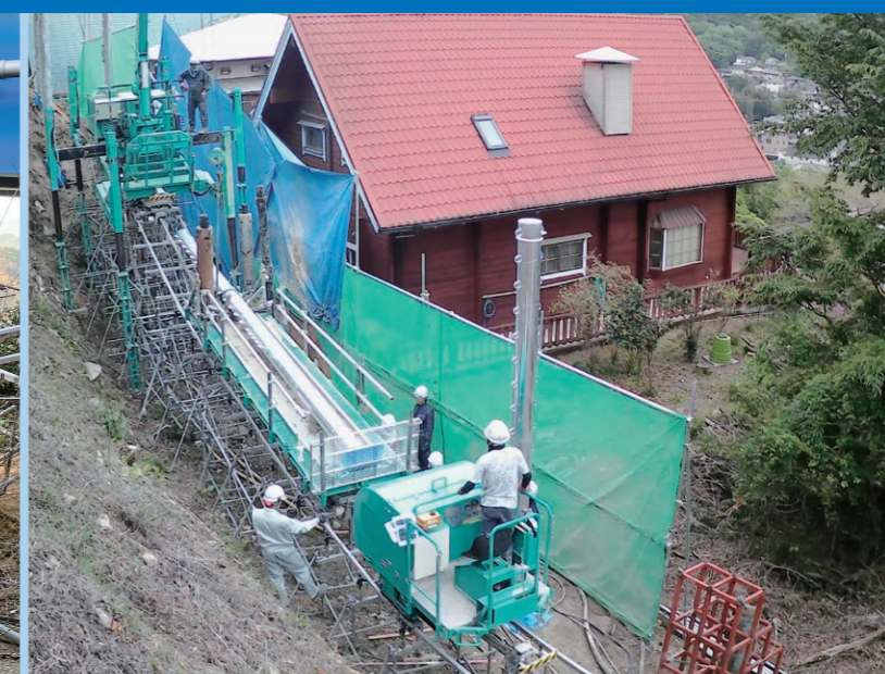
前押し台車を使用することで作業半径を短縮
