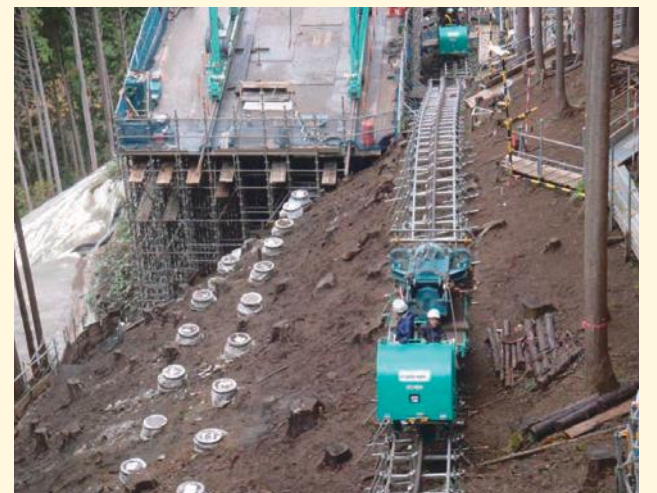
施工が終了した区間を順次撤去
