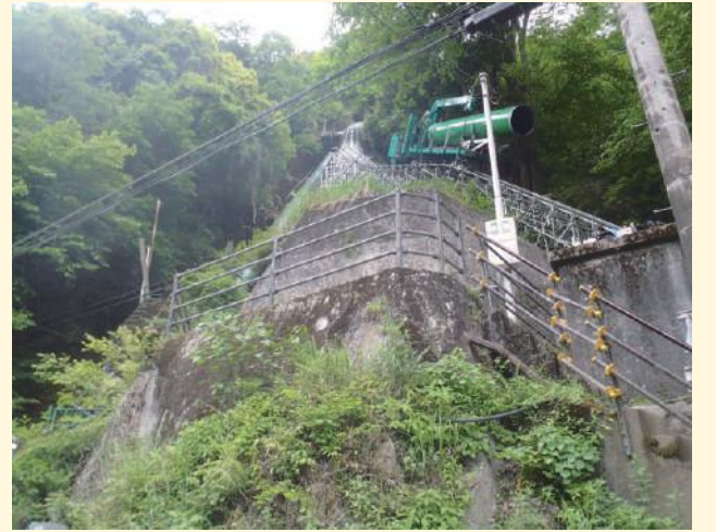
水圧鉄管沿いにレールを設置
