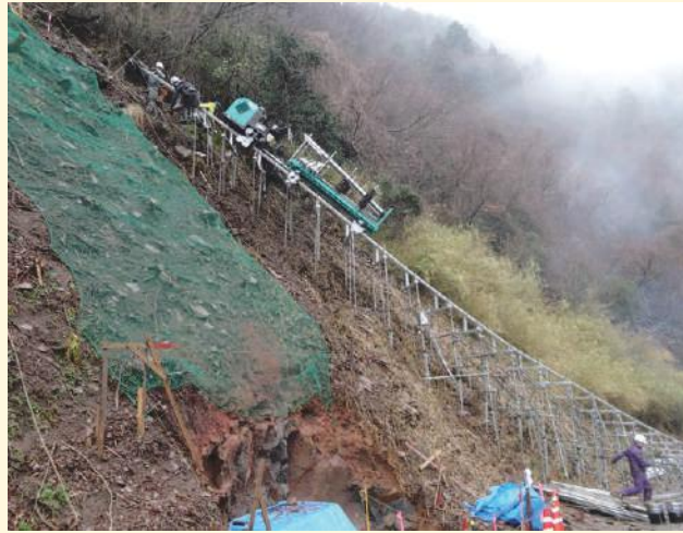
水圧鉄管敷設場所にレール設置
