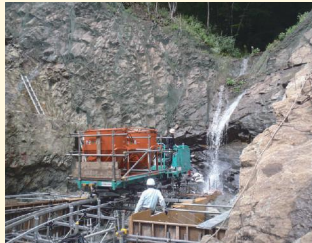
モノレールにて生コン運搬・打設
