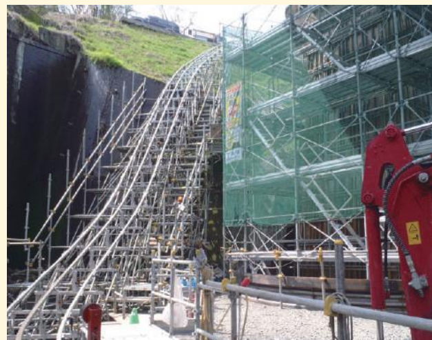
橋脚回りに足場、型枠・鉄筋を設置
