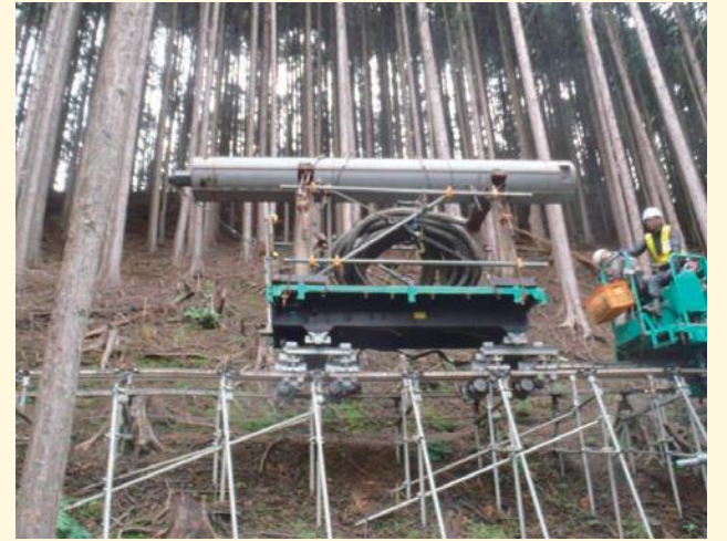
ダウンザホールハンマのハンマ部を運搬
