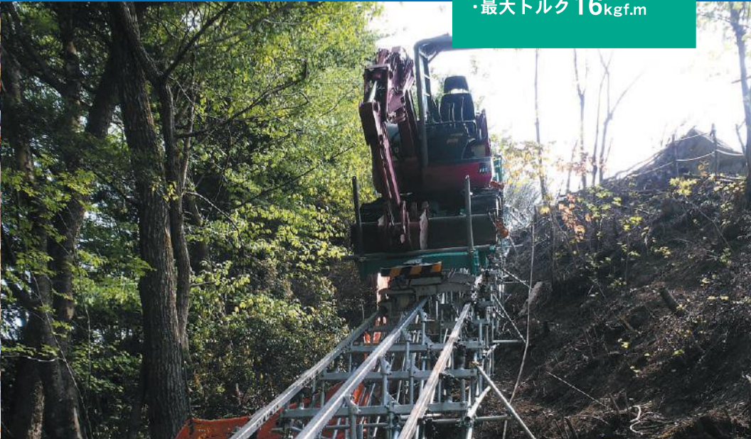
3tバックホウ運搬中
