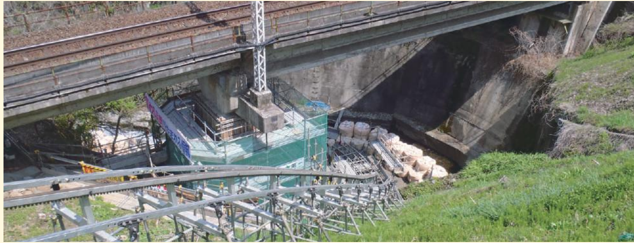
道路脇ヤードより線路下河川内の橋脚までレール設置
