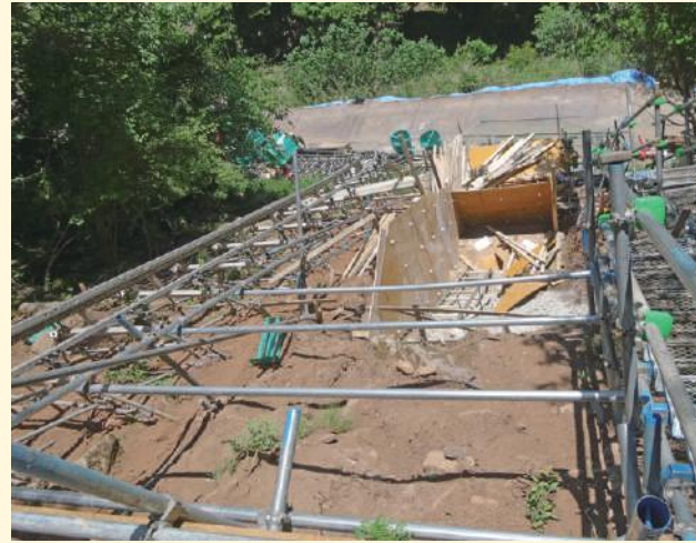
昇降階段設置、資材・型枠運搬
