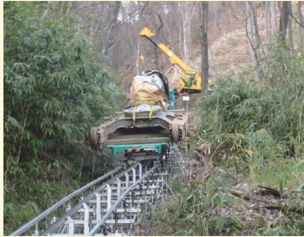
0.4mバックホウを分解して運搬中
