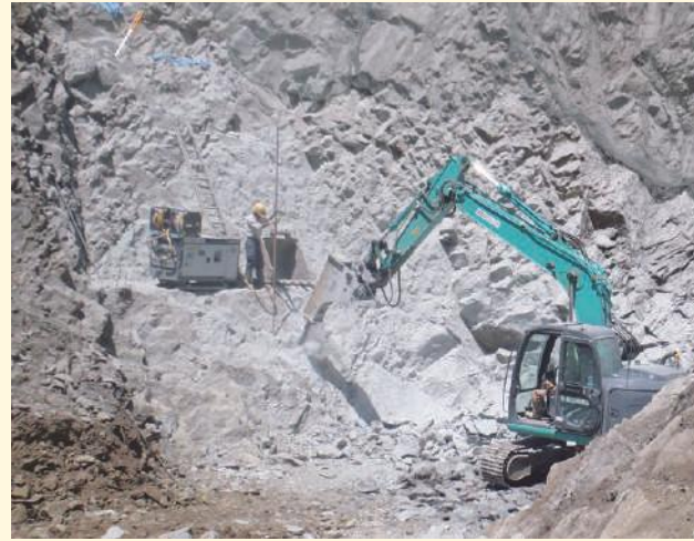
バックホウのブレイカーにて削岩
