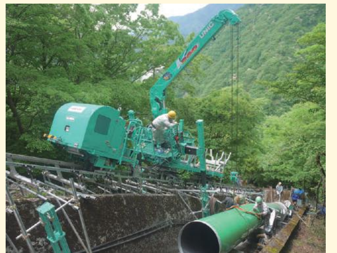
水圧鉄管を固定中
