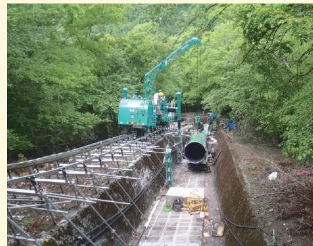
水圧鉄管を固定中
