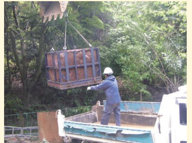
堀削土砂運搬中
