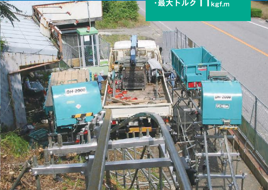
1t油圧ダンプ台車にて碎石搬出
