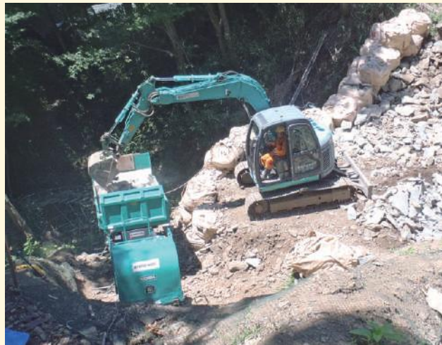
掘削土砂を2t回転ダンプ台車にて搬出
