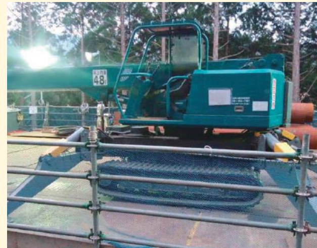
4.8tクローラークレーンを分解搬入
