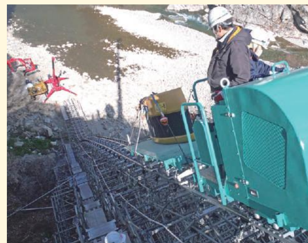
分解・運搬した部品をカニクレーンで組立
