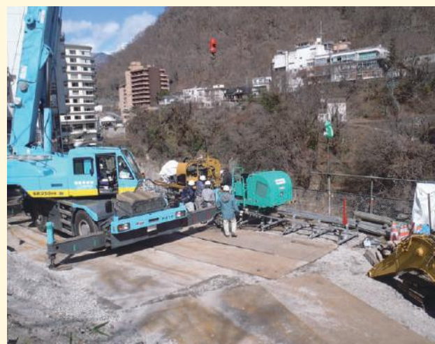
0.45m 3 バックホウを分解しモノレールで運搬
