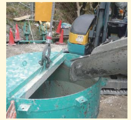
生コンホッパー天面を加工し運搬時の生コンがこぼれるのを防止
