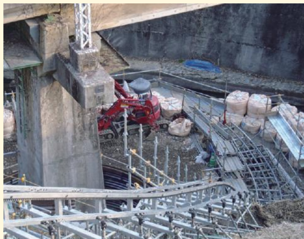
橋脚回りを掘削中
