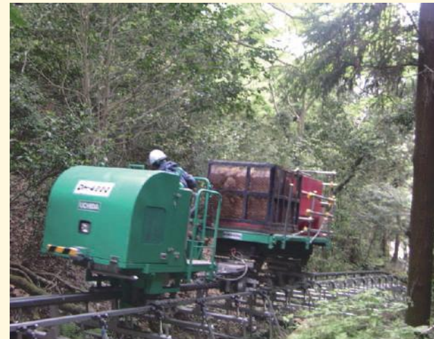
堀削土砂運搬中
