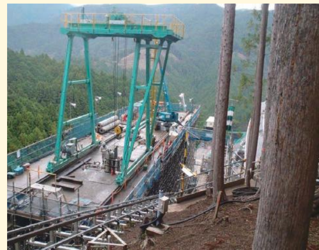
作業構台上に必要設備を設営し掘削
