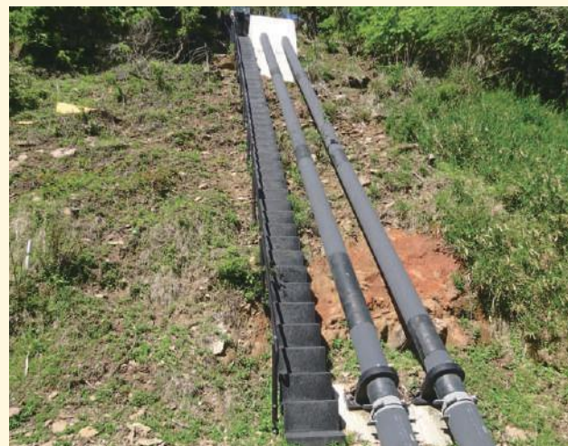
水圧鉄管完成
