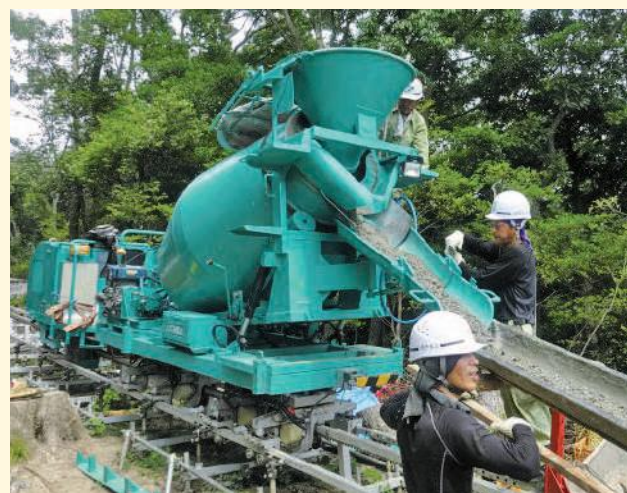
20m 3 /日の生コンを打設中
