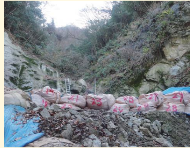
堰堤予定地堀削中
