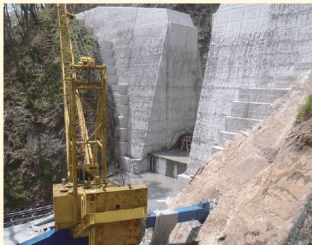
ジブクレーンを現場組立
