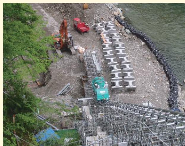
護岸ブロック、生コンを順次運搬
