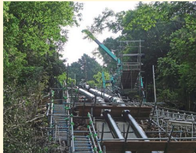
2tクレーン台車にて水圧鉄管敷設中
