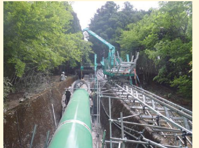
2tクレーン台車にて水圧鉄管を吊下げ中
