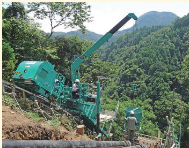
2tクレーン台車にて生コン打設
