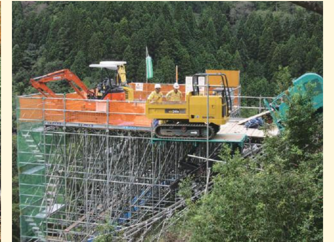
2tキャリアダンプを運搬
