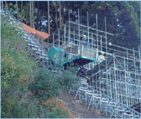
3tバックホウ 作業ステージに自走移動中
