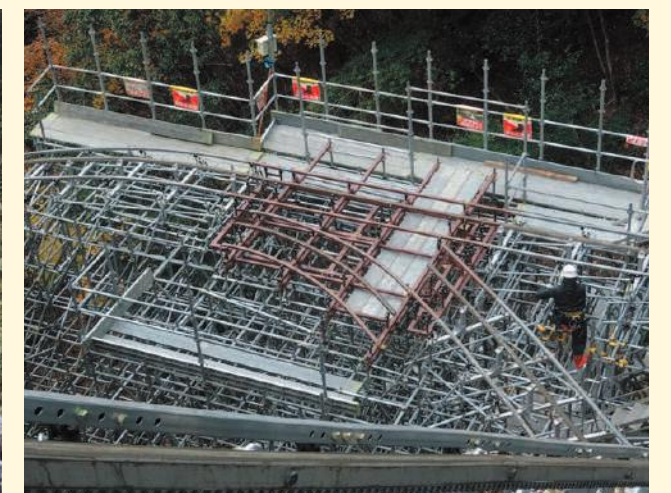
上部より切替ポイントを見下ろす
