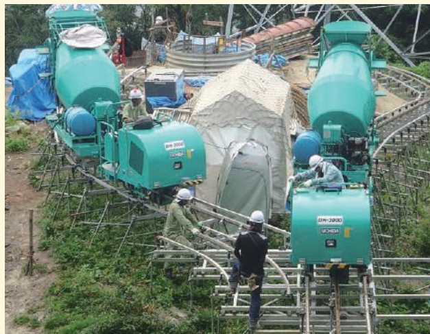
生コン打設に1mミキサー台車を使用し品質の良い生コン運搬
