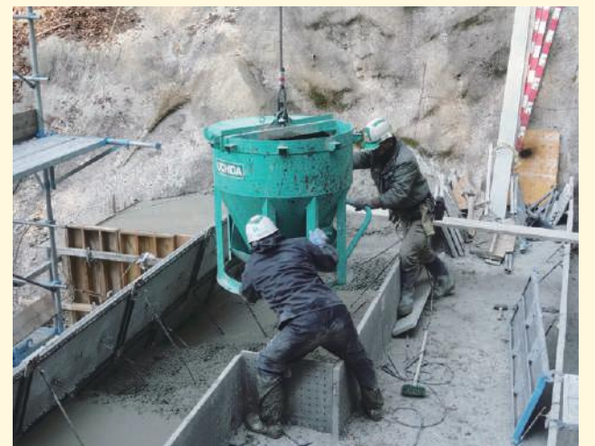
既設のタワークレーンで打設
