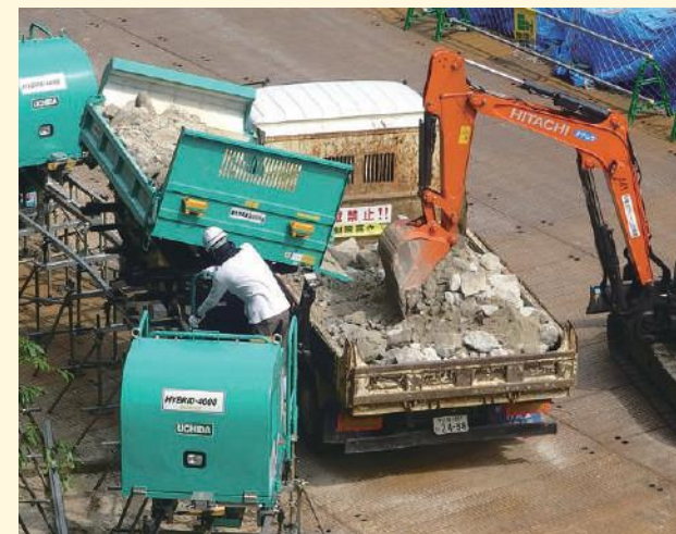
2t三転ダンプ台車で土砂を一括排出
