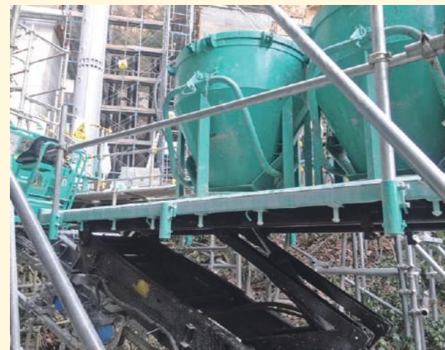
生コンホッパー0.5㎡を使用し運搬
