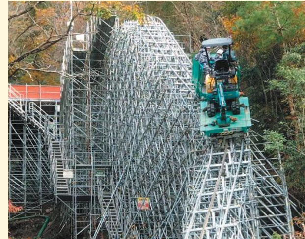
高低差最大12mの傾斜を登降し安全に重機運搬中
