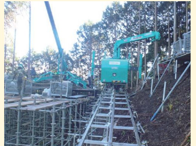
2tクレーン台車で作業構台材料を運搬
