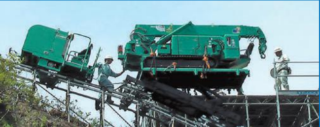
フラットデッキダンプにて3.7tクローラークレーン運搬中
