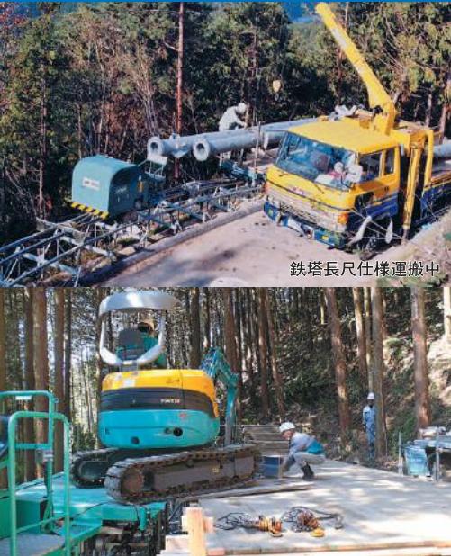
3tバックホウ 作業ステージに自走移動中
