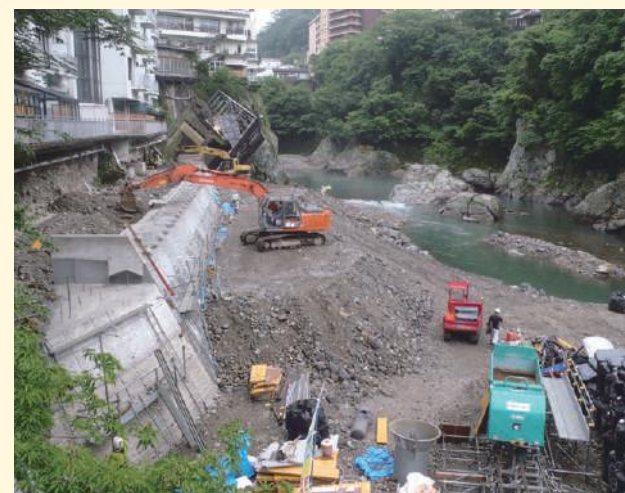
護岸ブロックを積み上げ施行中
